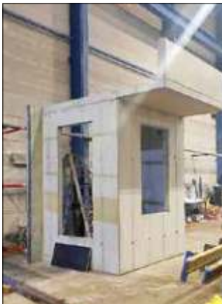
Musterbauteil vor der Schalung
