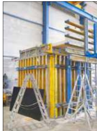
Musterbauteil in Schalung kurz vor dem Versuch mit Schaummörtel
