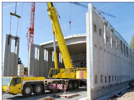
Montage der Schaumbeton-Elemente auf der Baustelle der ETA-Fabrik in Darmstadt
